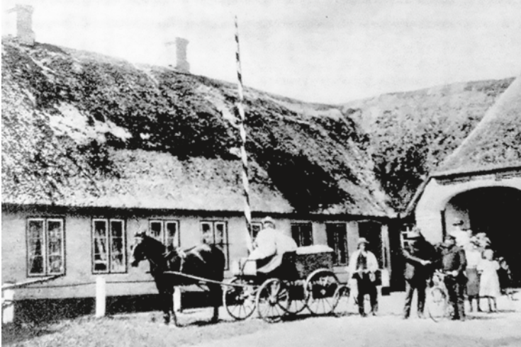
Eine Gastwirtschaft mit der sog. »Durchfahrt« an der Hauptstraße in Klixbüll.
